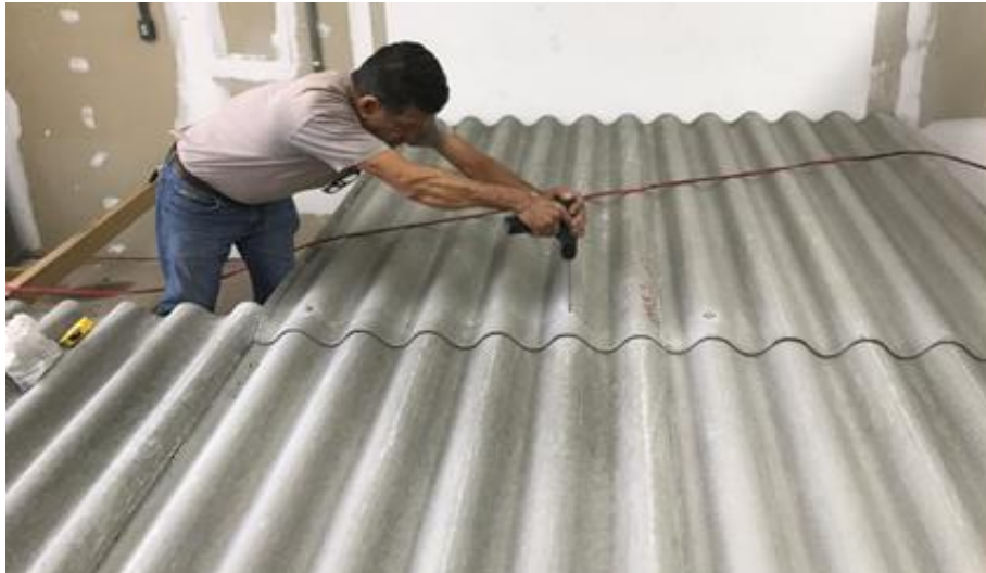
Figura 3 – Telhado constituído de telhas onduladas de fibrocimento sem amianto – tipo grandes ondas (GO) de 5 mm de espessura
