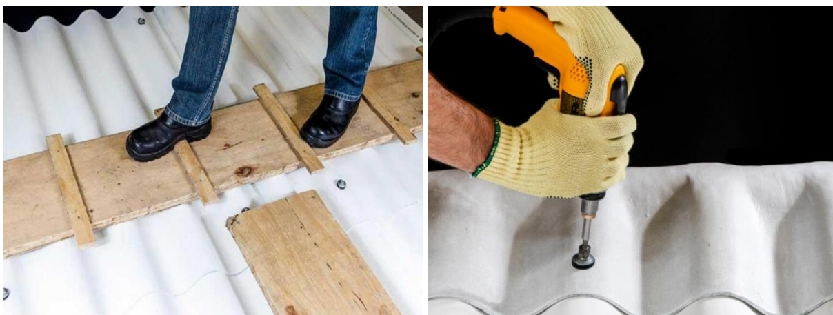
Figura 18 – Cuidados na montagem dos sistemas de cobertura constituídos por telhas onduladas de fibrocimento sem amianto – tipo grandes ondas (GO) de 5 mm de espessura
